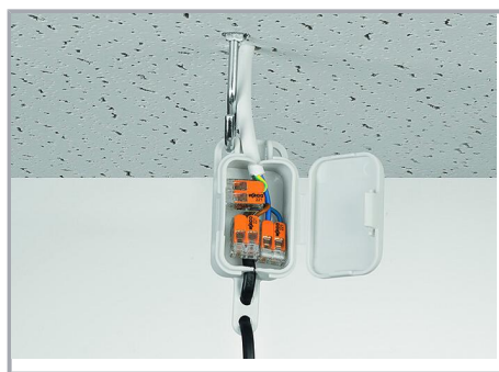
Montaż lamp wiszących w podwieszanym suficie
